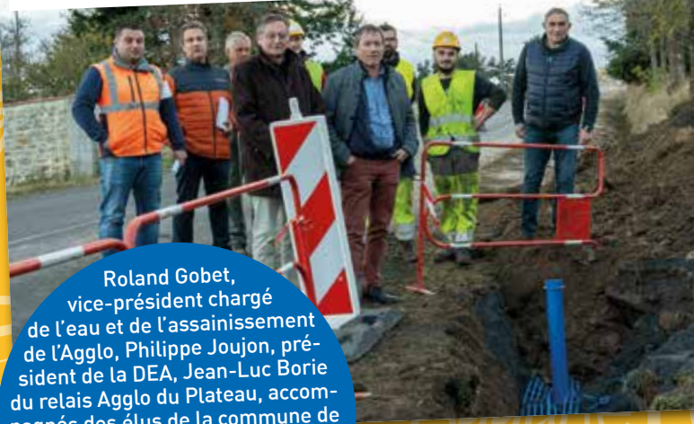
FÉLINES : TRAVAUX DE RENOUVELLEMENT DE CANALISATIONS DE DISTRIBUTION D'EAU.
